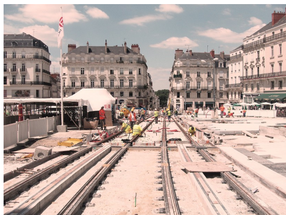
Travaux du tramway Place du Ralliement, 2010
